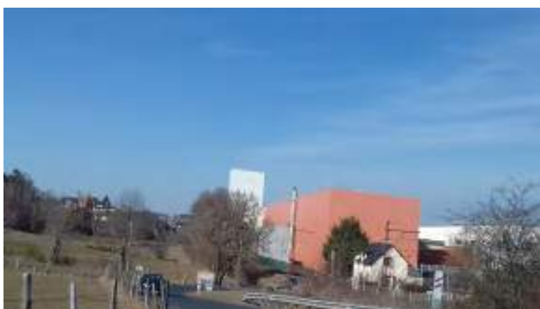
Usine Arcelor-Mittal de Saint-Chély-d'Apcher
