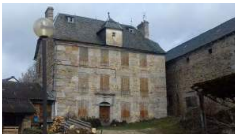
Immeuble vacant remarquable à Saint-Pierre-le-Vieux
